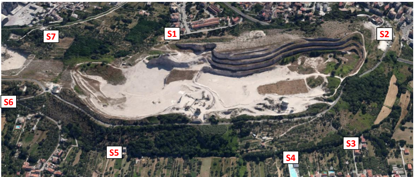
Foto n. 5 – I punti di misura
