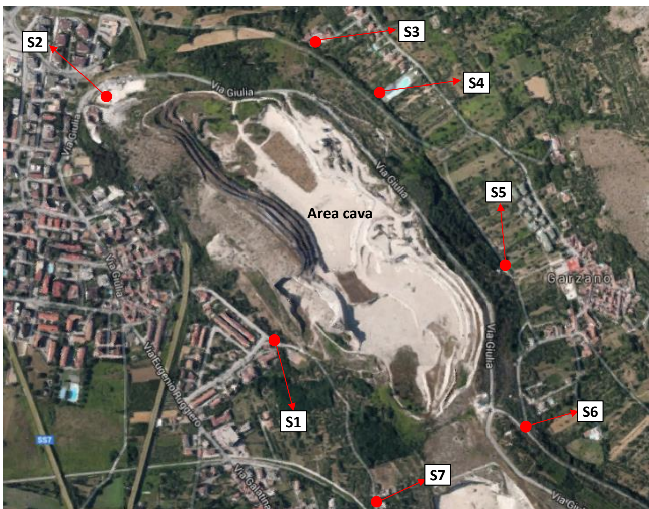
Foto n. 4 – Ubicazione dei punti di misura
